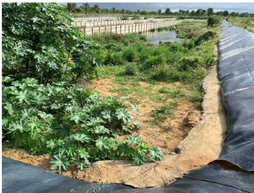
FIGURA 13 – Lagoa de Maturação (ETE) – Embasa/2021
