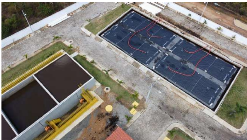
Figura 9 – ETL da Estação de Tratamento do Sisal em São José do Jacuípe - EMBASA 2021.
