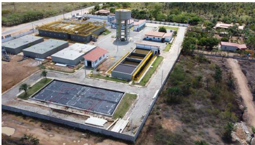
Figura 10 – Vista panorâmica da ETA Sisal - Decantadores, Floculadores, Filtros, Laboratórios e casa de Química; ETL – Bag's, Tanques de Equalização, Reservatórios de distribuição, e Lavagem - EMBASA 2021.
