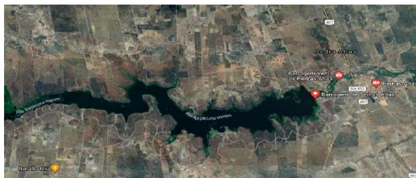
Figura 8: Barragem Pedras Altas – Capim Grosso BA; EMBASA 2021.
